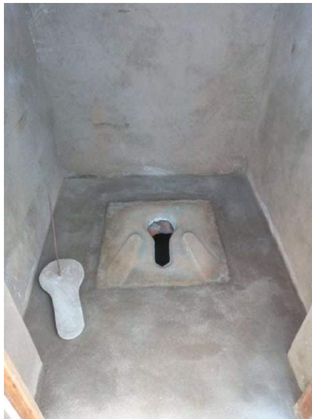
L'intérieur d'une cabine latrine
