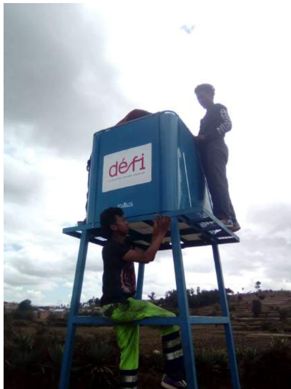
Le Château d'eau : réservoir d'eau puisée par la pompe
