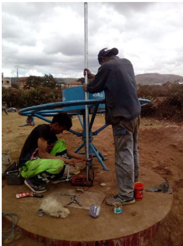
Installation de la play-pump ou pompe à manège
