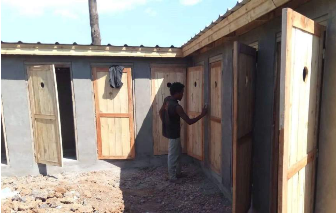
Mise en place de 8 nouvelles cabines latrines, pour remplacer les 3 existantes et insalubres
