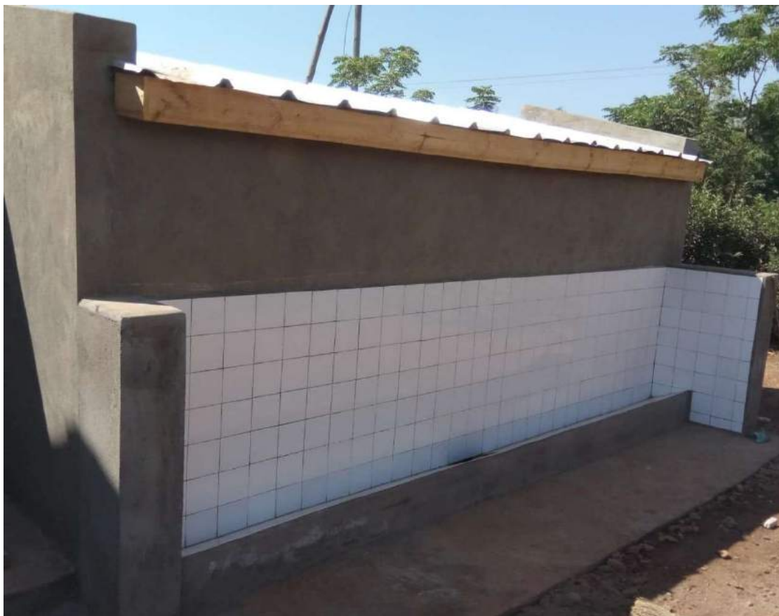
Réalisation d'une pissotière
